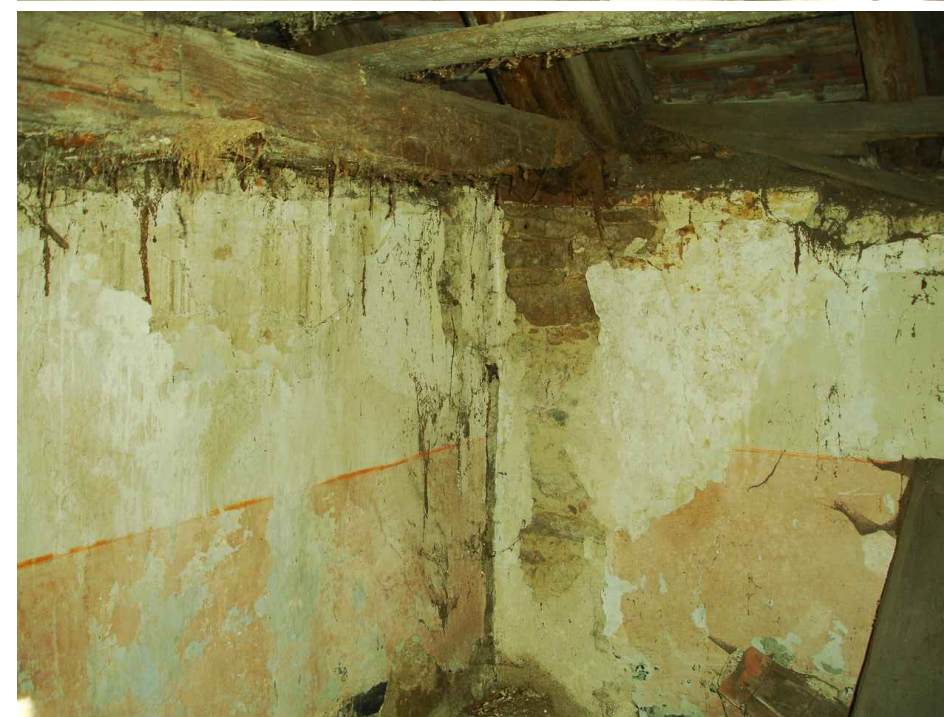
Místnost 2.03 schodiště na půdu uhnílé zhlaví trámů nad schodištěm
