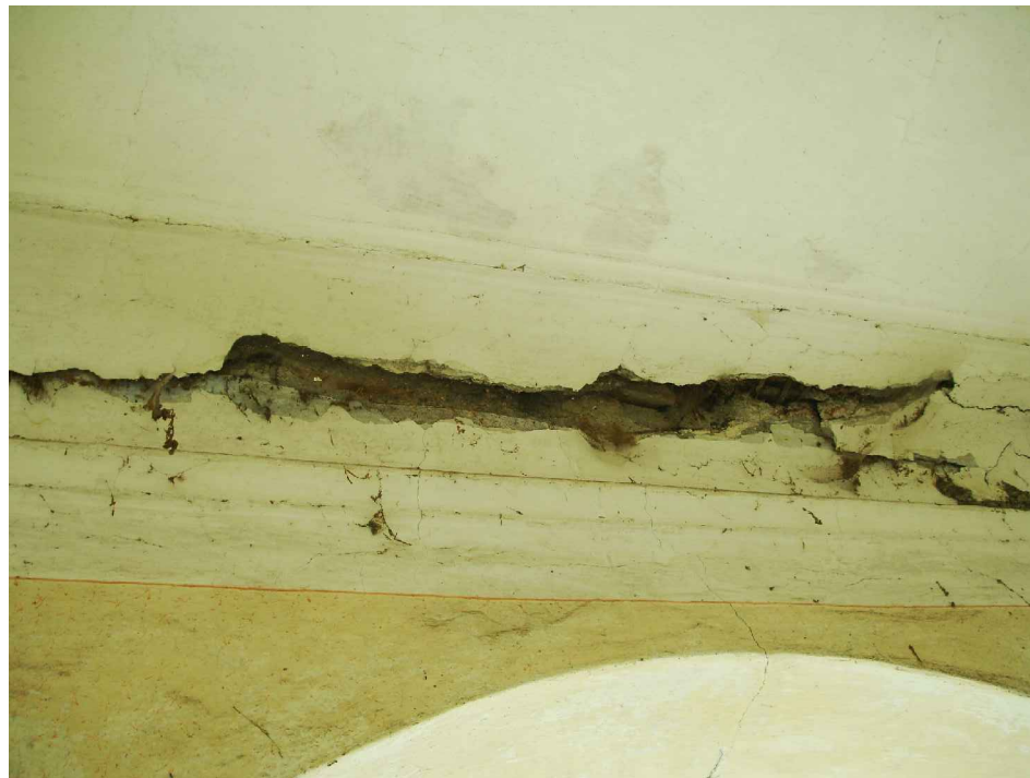
Místnost 2.05 trhlina ve fabionu
